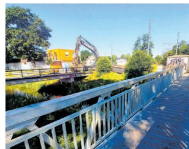
Die Behelfsbrücke ist jetzt befahrbar, der Abriss des bestehenden Bauwerks hat begonnen.
