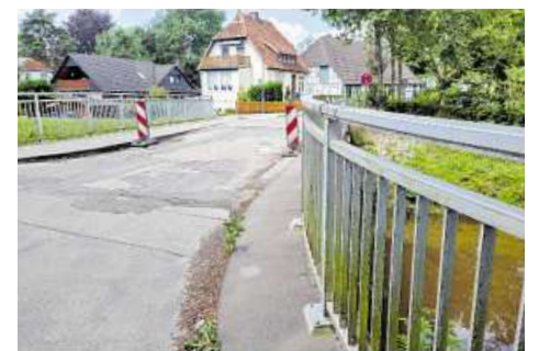
Die Wörpebrücke in der Klosterstraße wird ertüchtigt und saniert. Ab dem 19. August bleibt der Übergang für Autos, Radfahrer und Fußgänger gesperrt. FOTO: LUTZ RODE
